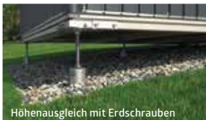
Höhenausgleich mit Erdschrauben
